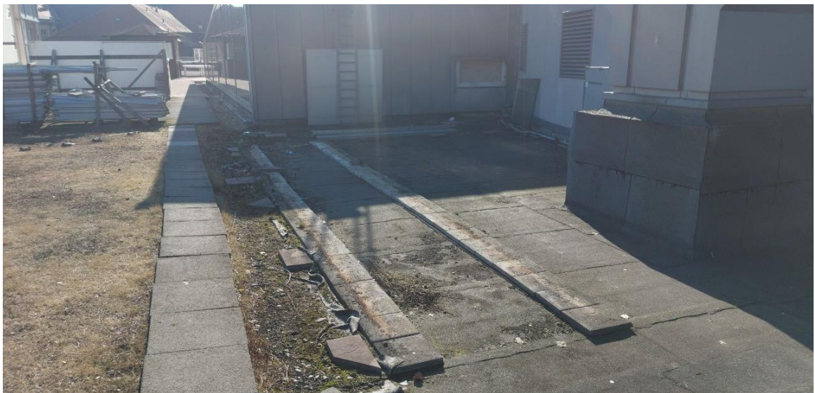
Abbildung 6: Demontiertes Außengerät, Vordach JenTower, eigenes Foto, Blick nach W.
