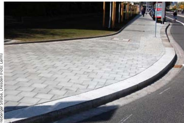
Hauptbewegungsrichtung des Gehwegbelags läuft durch, auch bei großen Ausrundungen
