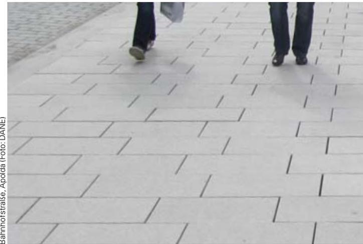
Vermeidung von Kreuzfugen zur besseren Verbundwirkung und Betonung der Hauptbewegungsrichtung
