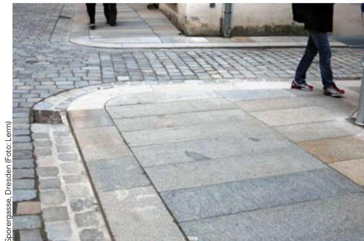
Eckausbildung: Hauptbewegungsrichtung des Gehwegbelags läuft durch, die untergeordnete Bewegungsrichtung stößt an
